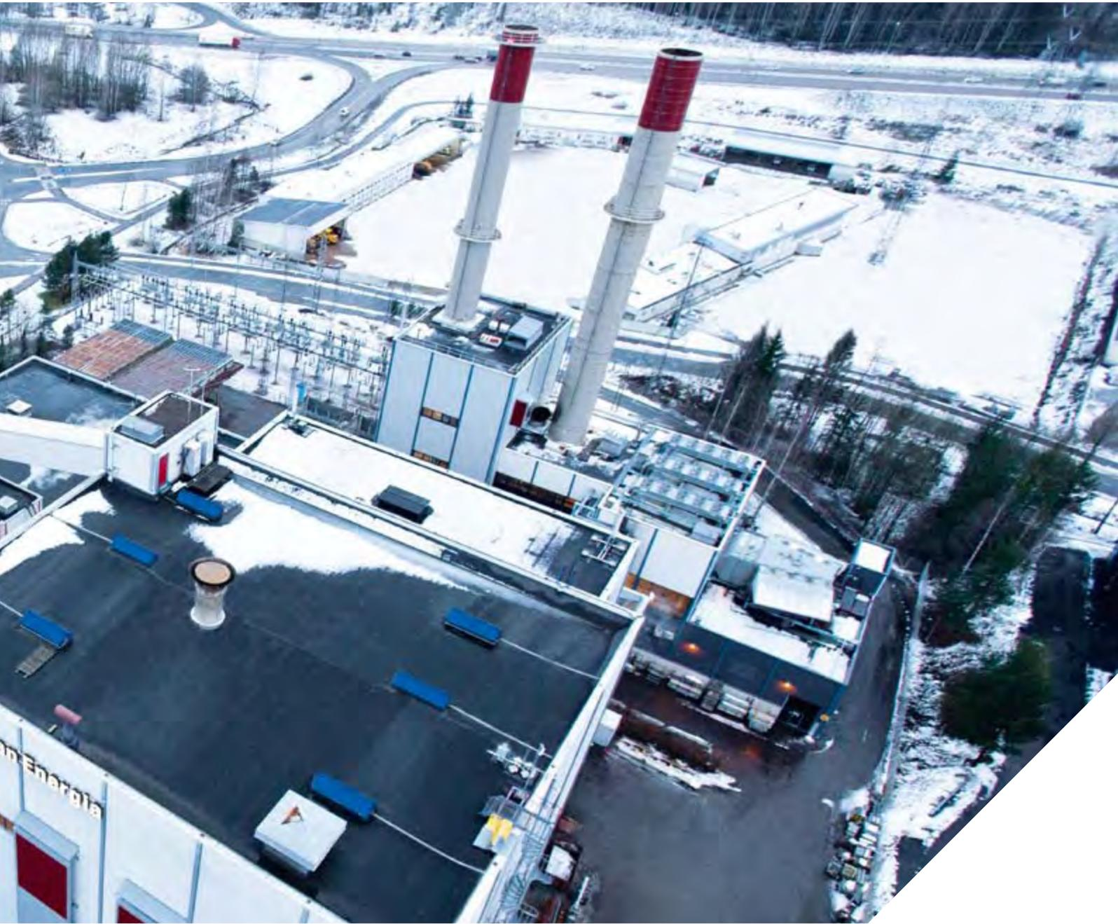
Das Kraftwerk Martinlaakso aus der Vogelperspektive. Vantaan Energia, ein kommunaler Energieversorger im Eigentum der Städte Vantaa und Helsinki, erzeugt hier mit einer Kapazität von 195 MW Strom und durch energieeffiziente Nutzung der dabei anfallenden Wärme gleichzeitig 330 MW Fernwärme.
